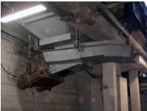
Reparaciones de A-55
